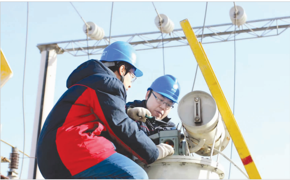
近期,国网阳泉供电公司变电检修中心加大设备巡检力度,加强隐患排查、异常参数分析,全力做好变电站的防雷、防覆冰、防风工作,确保春节期间市民用电安全。 贺 海摄
