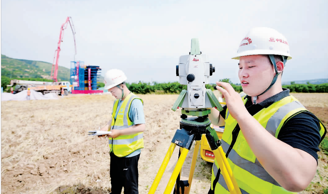
6月9日,在四十高铁陕西段建设现场,中铁上海工程局的施工人员在浇筑桥墩前测量放样。当日,西(安)十(堰)高铁沪河特大桥13号桥墩顺利完成浇筑。这是四十高铁陕西段全线浇筑完成的首个桥墩。
