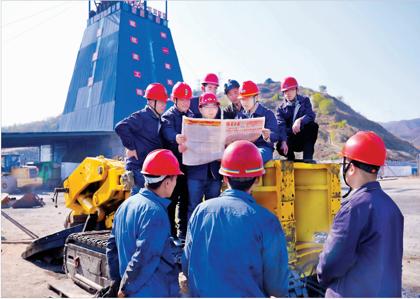
十月二十四日，西上庄煤矿建设者在工余时间学习党的二十大精神。南煤集团西上庄年产五百万吨煤矿及选煤厂项目，是省、市重点工程，自二〇一九年开工以来，广大建设者按照工程节点的斗志，更加过硬的措施，加快工程进度，确保项目早日建成投产。 张泽慧 摄
