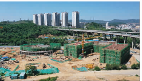
郊区职业高级中学新校区建设现场
