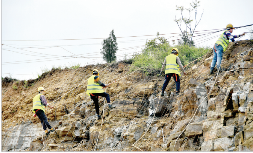
“五一”小长假期间,在狮脑山路地质灾害治理工程施工现场,工人们放弃休息,坚守在施工一线,在劳动中度过节日。 晋向华摄
