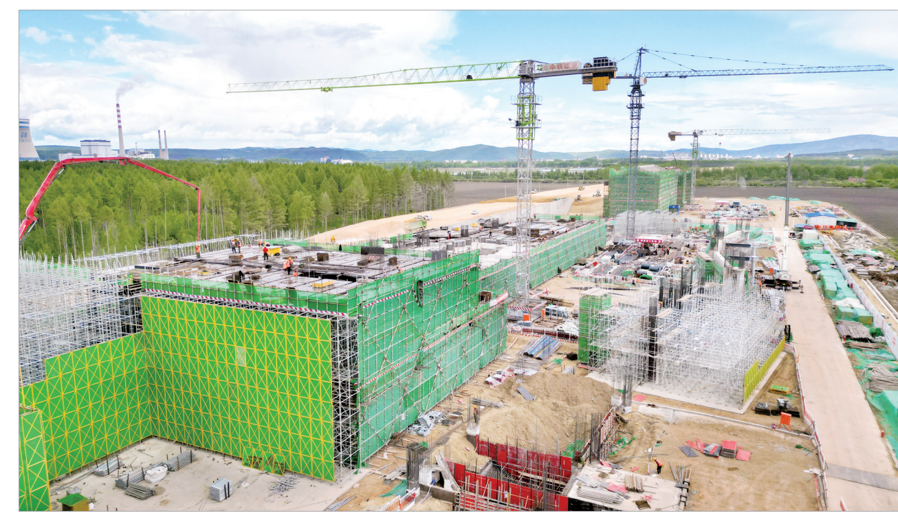
中国最北高铁站伊春西站主体结构施工火热推进。图为伊春西站主体结构施工现场(无人机照片)。伊春西站是哈尔滨至伊春首条在建速度最高、首个在高寒地区多年冻土层施工的高铁站房。伊春西站是哈伊高铁全线新建最大站房。哈伊高铁(哈尔滨至伊春)起自黑龙江省哈尔滨市,终至黑龙江省伊春市,正线全长318公里,设计时速250公里。哈伊高铁全线建成后,哈尔滨至伊春旅客列车运行时间将由现在的7小时左右缩短至2小时左右。新华社记者王松摄
