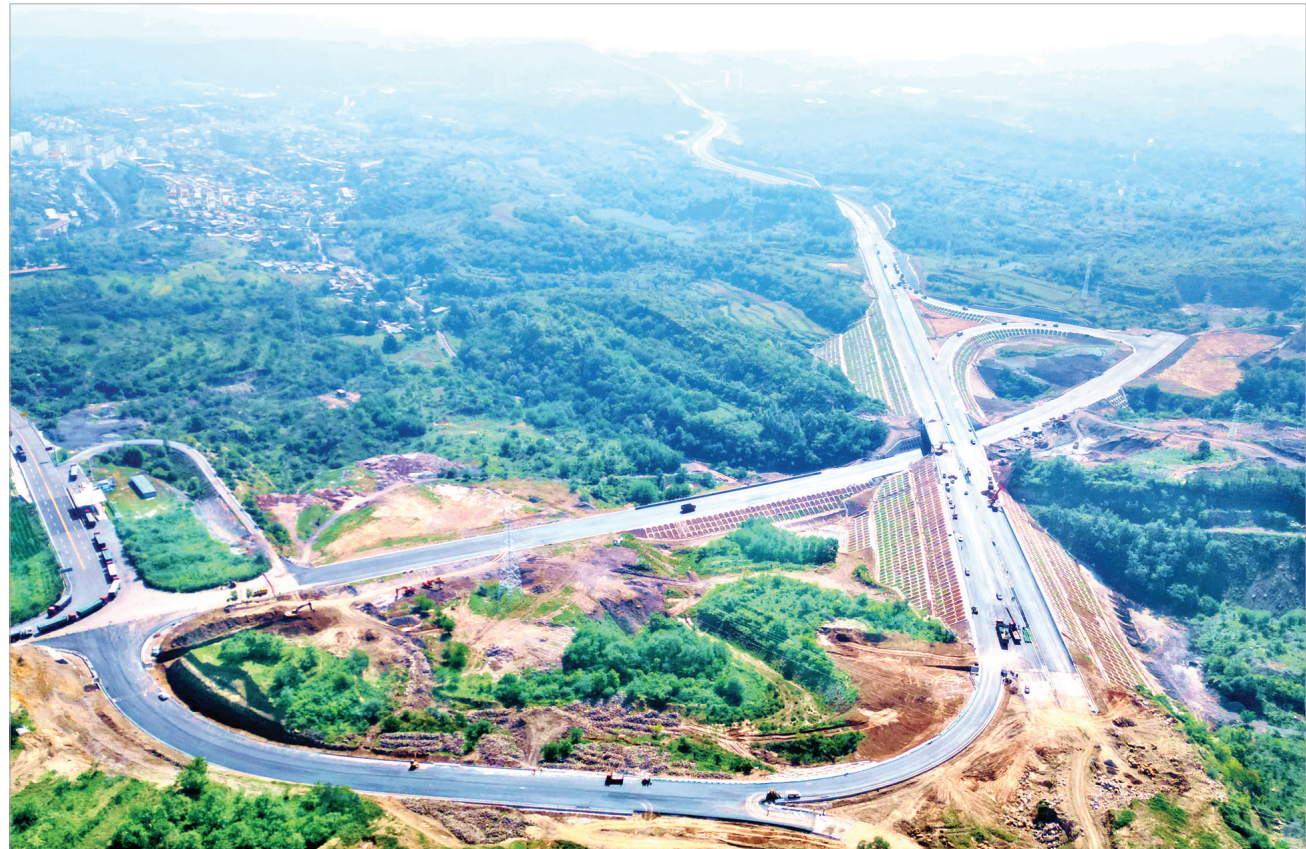
目前,国道239线阳泉郊区过境河底至荫营段改线工程的河底互通立交主桥施工点,各项工程正在加速有序推进。该项目进入最后冲刺阶段,预计9月底全线通车。国道239线阳泉郊区过境河底至荫营段改线工程是省、市、区重点项目,是郊区创新投资形式实施的第一项PPP工程,其中荫营镇上千亩坪村经三都特大桥、苇泊特大桥到河底镇龙光峪段工程已于去年年底建成。图为9月21日,无人机拍摄的河底互通立交主桥施工点施工现场。 刘胜摄
