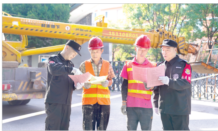
9月18日,南山公园改造提升工程正在热火朝天地进行。阳泉市城区保安服务有限公司作为公园安保力量,为保证工程顺利进行,采取24小时巡逻、重点点位值守等措施。图为城区保安服务有限公司保安向施工工人发放安全知识宣传单,增强其安全意识,营造安全施工环境。张泽慧摄
