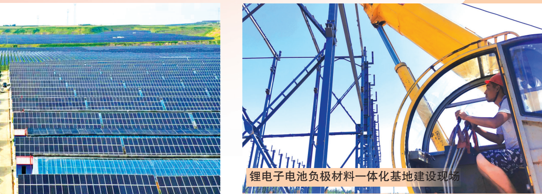
锂电池负极材料一体化基地建设现场
