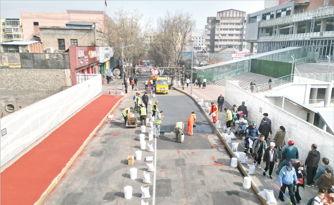
日前,在德胜东街天桥路维修工程现场,施工人员有序施工。该工程由市市政工程管理处采用新型绿色环保型材料进行半封闭施工。工程完工后,将提高该路段抗高温、抗滑、降噪性能,优化道路防水、防腐性能,延长道路使用寿命。
