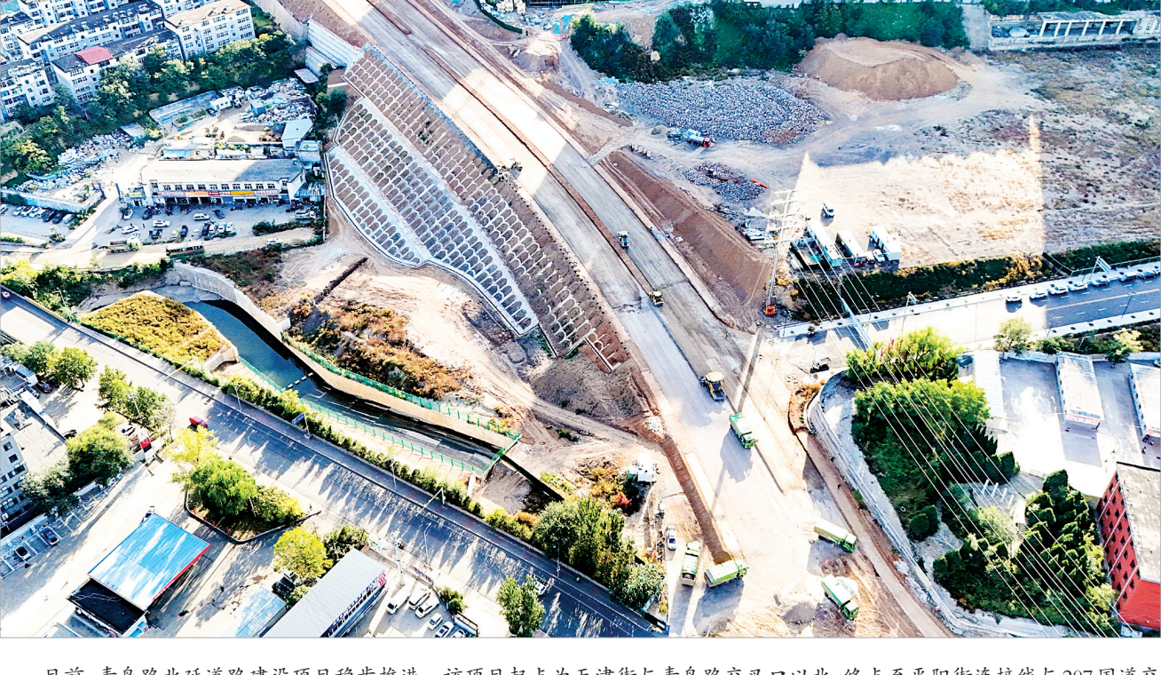
目前，青岛路北延道路建设项目稳步推进。该项目起点为天津街与青岛路交叉口以北，终点至平阳街连接线与207国道交叉口，全长447.9米，预计2025年初具备通车条件。项目建成后，将为高新区建成区东部增加一条向北出入口，既可以减轻周边区域交通压力，进一步完善我市城市路网结构，又可为沿线经济发展及土地开发利用开辟新空间，为青岛路科研创业园的建设提供有力支撑。图为10月11日，工人进行道路水稳层施工。
