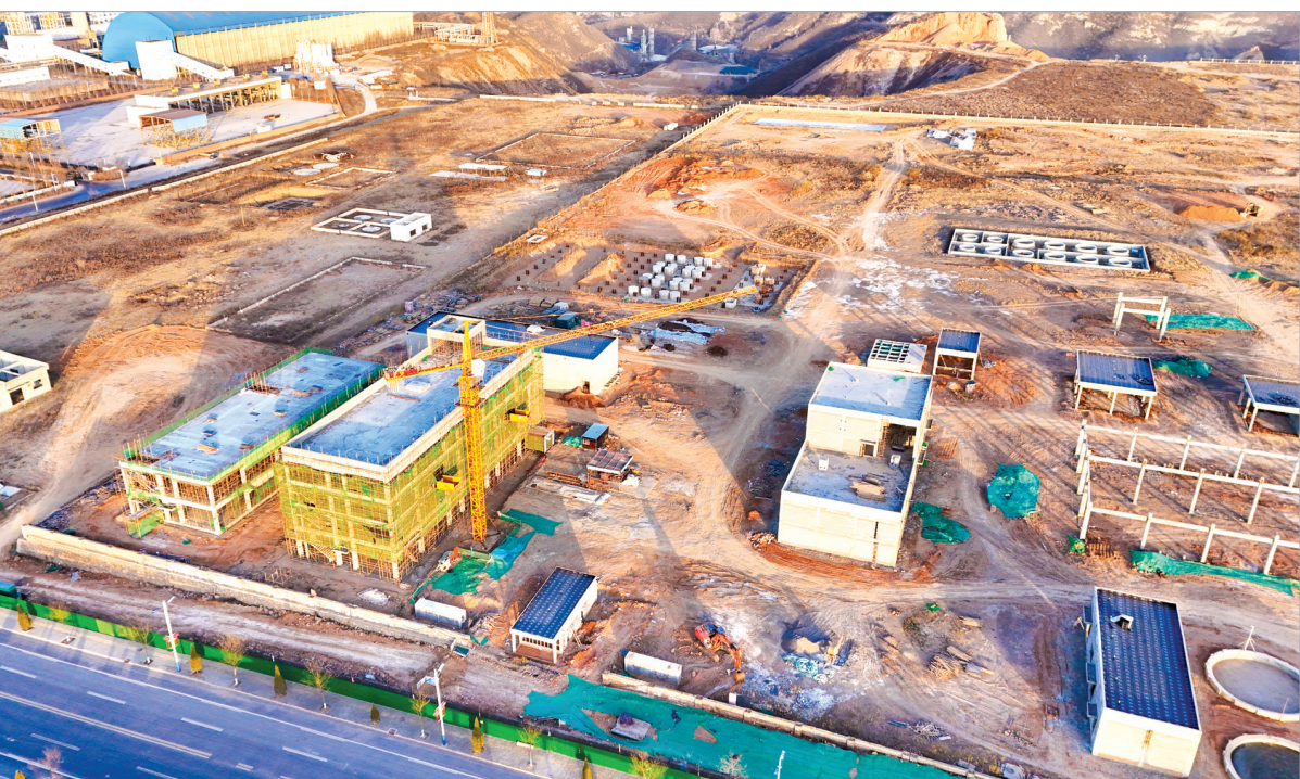
山西湖大特塑新材科技有限公司年产10000吨聚碳系列产品项目位于平定经济技术开发区龙川化工园区内。项目分两期建设,建设内容包括聚碳车间、研发中心,以及储运、公辅和环保设施等。目前,项目土建工作已完成约40%,办公楼、化验楼、中控楼、公用工程楼4个单体于日前封顶,预计6月30日之前投产。 图为1月2日,无人机拍摄的项目建设现场。
