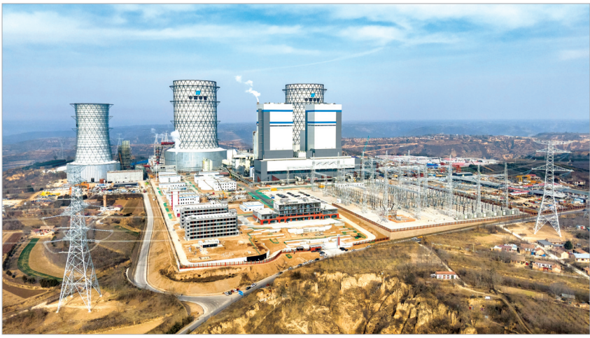
这是1月3日拍摄的华能正宁电厂（无人机照片）。近日，华能正宁2×1000兆瓦调峰煤电项目1号机组并网发电。华能正宁电厂位于甘肃省庆阳市正宁县，是华能陇东多能互补综合能源基地的重要组成部分，是陇电入鲁工程的重点配套电源。待两台机组全部并网后，年发电量将达100亿千瓦时，保障陇电入鲁特高压线路安全稳定运行。 新华社记者 郎兵兵摄
