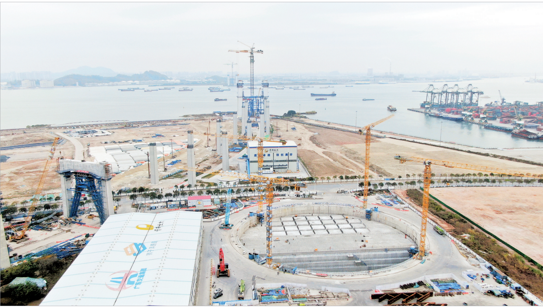
这是狮子洋通道主桥狮子洋大桥施工现场（2月6日摄，无人机照片）。 新春伊始，粤港澳大湾区超级工程狮子洋通道项目建设现场一派繁忙景象。项目主桥狮子洋大桥等关键线路32个施工点已全面复工复产。 狮子洋通道是继港珠澳大桥、深中通道后，粤港澳大湾区又一超级工程。项目为东西走向多层复合公路通道，其控制性工程狮子洋大桥采用主跨2180米、双层钢桁悬索桥“一跨过江”。项目建成后，将为珠江口东西两岸融合发展开辟新的重要通道。 新华社记者王瑞平摄
