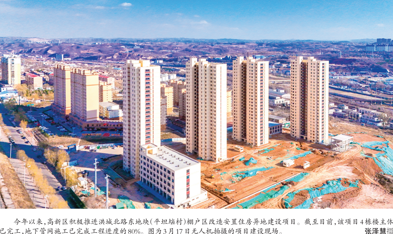
今年以来,高新区积极推进洪城北路东地块(平坦墙村)棚户区改造安置住房异地建设项目。截至目前,该项目4栋楼主体已完工,地下管网施工已完成工程进度的80%。图为3月17日无人机拍摄的项目建设现场。
