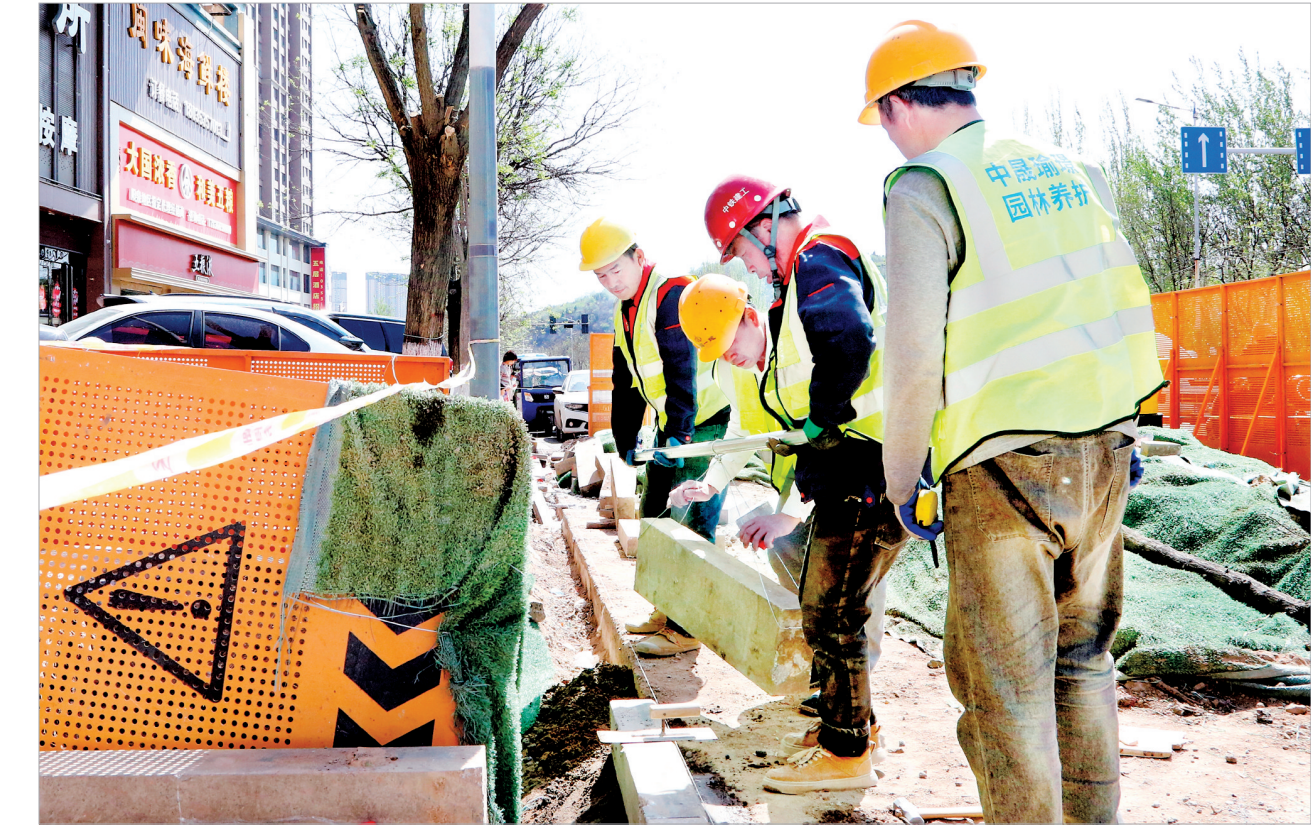
近日,我市启动公交站台改造工程,对市区12个站点实施港湾式改造,对62个站点进行适老化无障碍改造。此次改造通过拆除原有直线站台、拓宽道路、消除高差、增设无障碍通道等措施,缓解公交车停靠引发的交通拥堵,提升乘客上下车安全性和便利性。图为4月15日,施工人员在桃北东街农贸市场西侧进行公交站台结构优化。 杨园园摄
