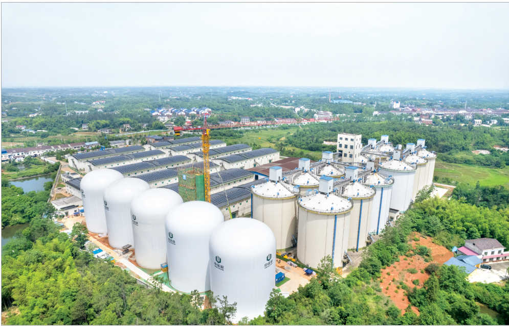
这是5月6日在中储粮长沙直属库拍摄的气膜粮仓建设施工现场(无人机照片)。
