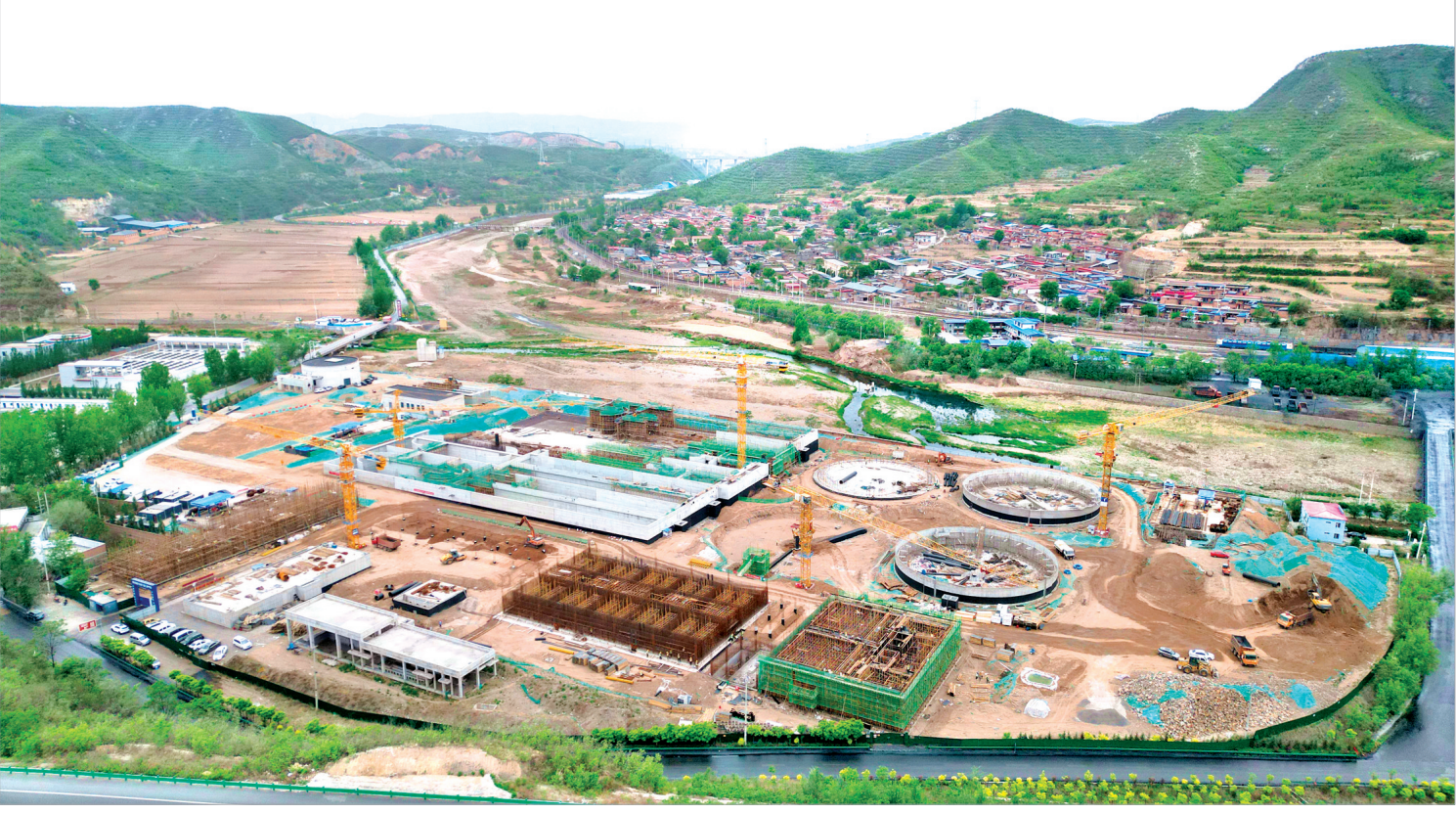
阳泉市新建污水处理厂项目各项工程有序推进。目前,该项目主体结构已完成 80%,完成投资 1.5 亿元,预计年底完工。
