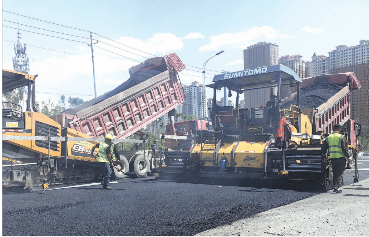
五月十八日,阳泉公路分局组织施工队伍,利用大型机械,加班加点对国道二三九线李家庄至平阳街万达路口路面进行沥青路面提标铺筑施工,改善公路通行条件。 冯梦琪摄
