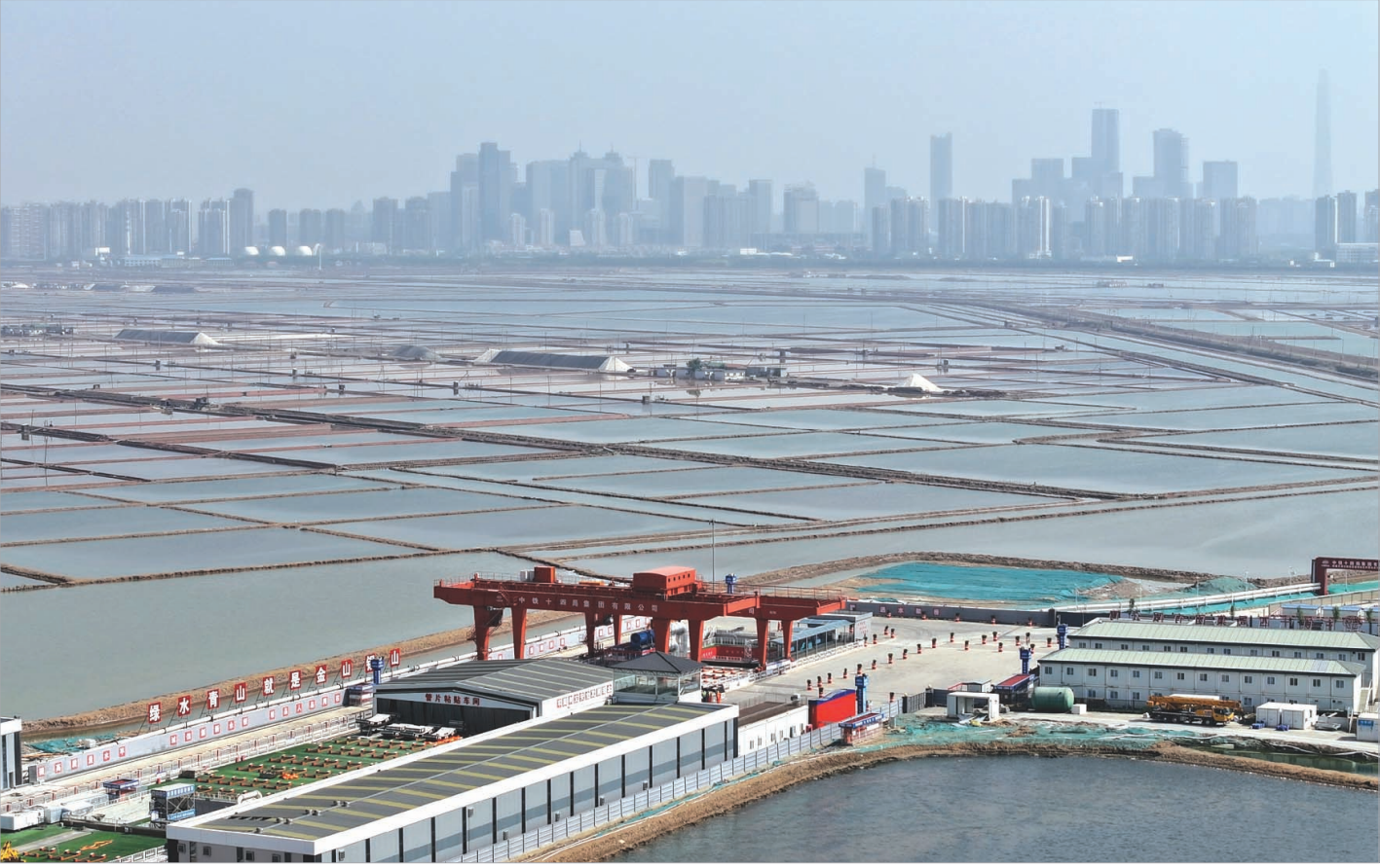
5月19日拍摄的津潍高铁津沽海河隧道盾构工区一角(无人机照片)。
