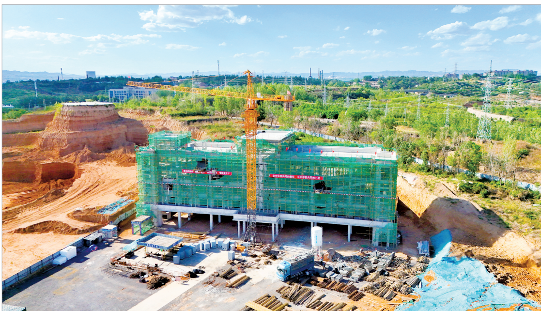
日前，阳泉高新区特勤消防站及配套消防训练设施项目主体顺利封顶。阳泉高新区特勤消防站及配套消防训练设施项目位于泉东工业园区。项目建成后，对提高城市公共消防设施建设水平、增强火灾防控和各种灾害事故的综合处置能力、保障人民群众生命财产安全具有重要意义。
