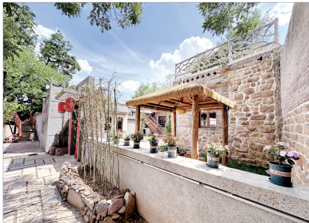
平定县冠山镇杨家沟村首批民宿建设接近尾声。郭鑫璐摄
