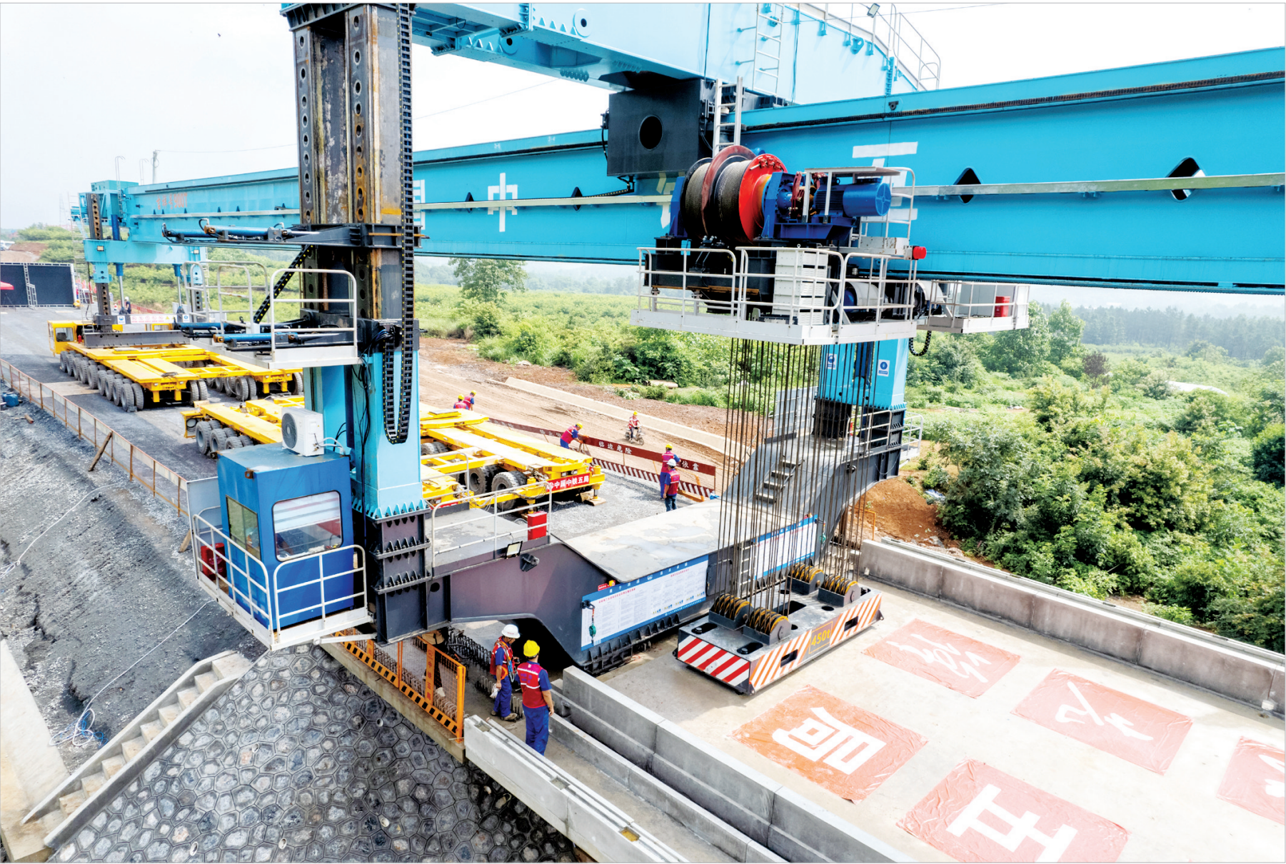
6月25日,在邵永高铁柘剌坪特大桥建设工地,中铁五局工人在进行架梁施工作业(无人机照片)。 当日,在位于湖南省永州市的邵(阳)永(州)高铁柘剌坪特大桥施工现场,由中铁五局承建的中铁五局二标段成功架设全线首孔箱梁,标志着邵永高铁全线箱梁架设工程正式启动。 邵永高铁全长约96公里,设计时速350公里,是我国“八纵八横”高铁网中呼和浩特至南宁通道的重要组成部分,北连娄底至邵阳铁路,南接衡阳至柳州铁路,邵永高铁建成后,对完善区域铁路网布局,促进中部地区高质量发展具有重要意义。 新华社记者陈思汗摄
