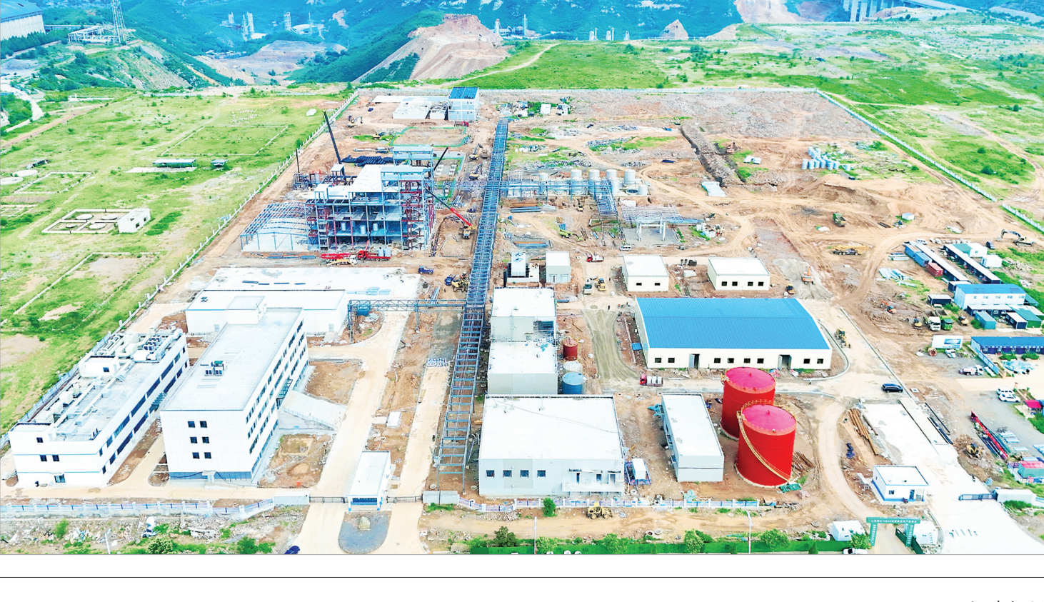
位于平定经济技术开发区龙川化工园区的山西湖大特年产10000吨聚羧系列产品建设项目进入冲刺阶段。目前，办公楼、中控楼、消防楼等18个建筑物和构筑物已完成施工；综合楼、化验楼及门卫室已投用，正开展道路及地下管网施工作业。
