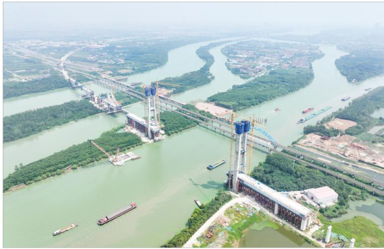
这是8月5日拍摄的沪渝蓉高铁跨京杭运河斜拉桥建设现场(无人机照片)。当日,由中国铁建大桥局承建的沪渝蓉高铁跨京杭运河斜拉桥主塔顺利封顶。至此,大桥核心支撑结构施工圆满收官,项目全面转入钢梁及斜拉索安装新阶段。该桥位于江苏扬州境内,是沪渝蓉高铁全线关键控制性工程,桥长564.3米,主跨300米。
