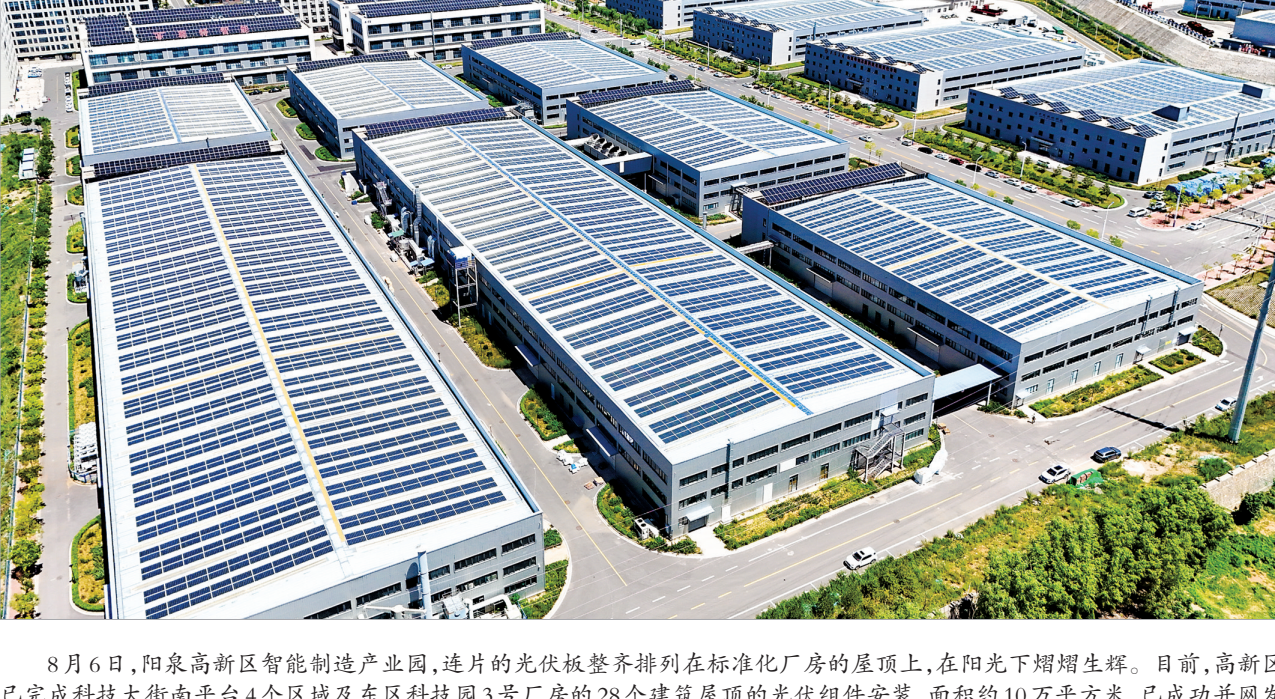
8月6日，陽泉高新區智能制造產業園，連片的光伏板整齊排列在標準化廠房的屋頂上，在陽光下熠熠生輝。目前，高新區已完科技大街南平台4個區域及東區科技園3號廠房的28個建築屋頂的光伏組件安裝，面積約10萬平方米，已成功并網發電，日均發電量4萬千瓦時。張澤慧攝
