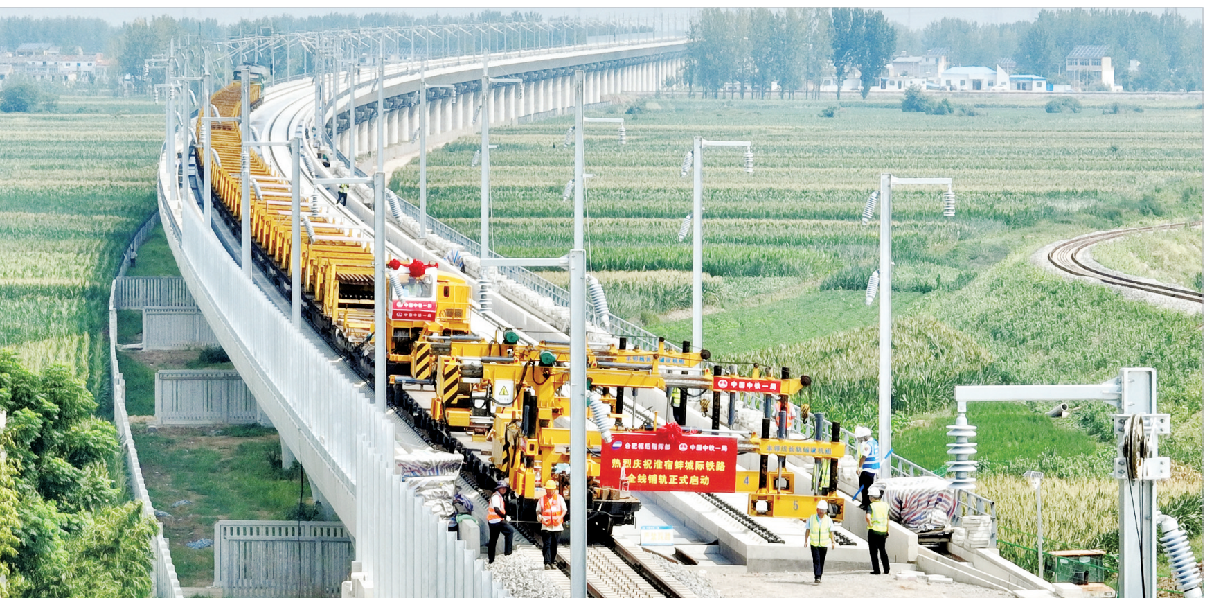
8月6日，中铁一局施工人员在淮宿蚌城际铁路铺轨施工现场作业(无人机照片)。
