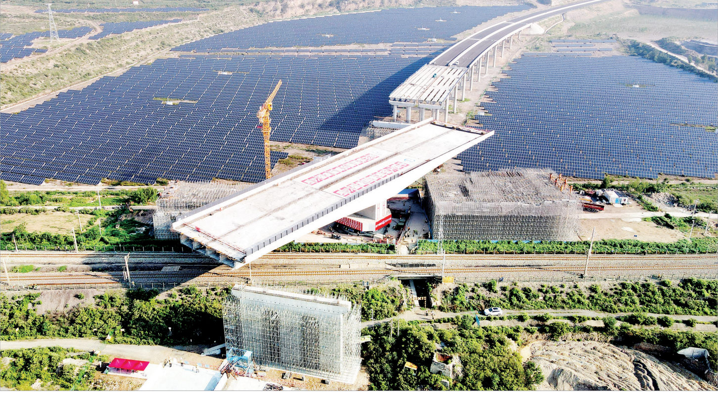
这是8月11日拍摄的河南省济源市沿太行山高速公路跨焦柳铁路立交桥转体施工现场(无人机照片)。
