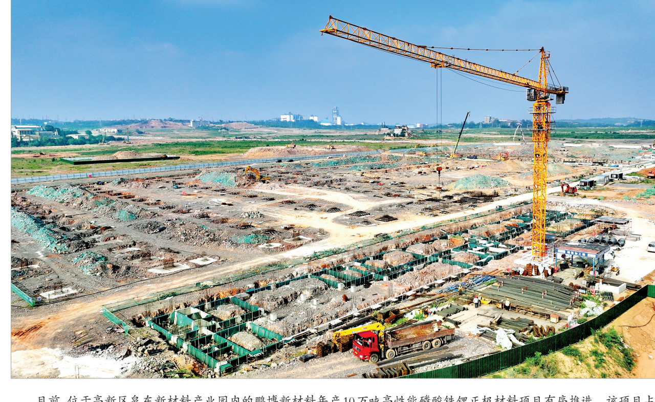
目前，位于高新区泉东新材料产业园内的鹏博新材料年产10万吨高性能磷酸铁锂正极材料项目有序推进。该项目占地70余亩，投资18.5亿元，规划建设8条现代化生产线。项目投产后年产值可达30亿元，带动300余人就业，助力我市打造百亿级新能源电池专业镇，推动能源革命与产业升级。图为8月13日拍摄的项目建设现场。
