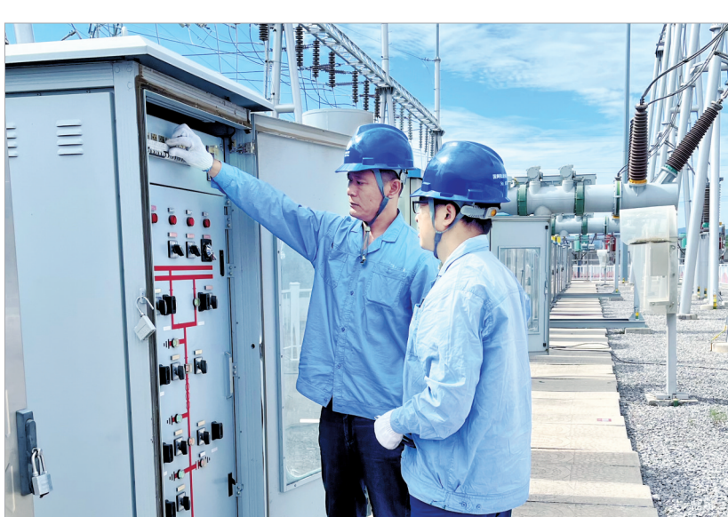
近日,国网阳泉供电公司变电检修中心检修人员在220千伏盂县变电站为110千伏线路的汇控柜和机构箱加装除湿装置。此次加装工作消除了设备隐患,为变电站内GIS设备的安全可靠运行增添了重要保障。 贺 海摄
