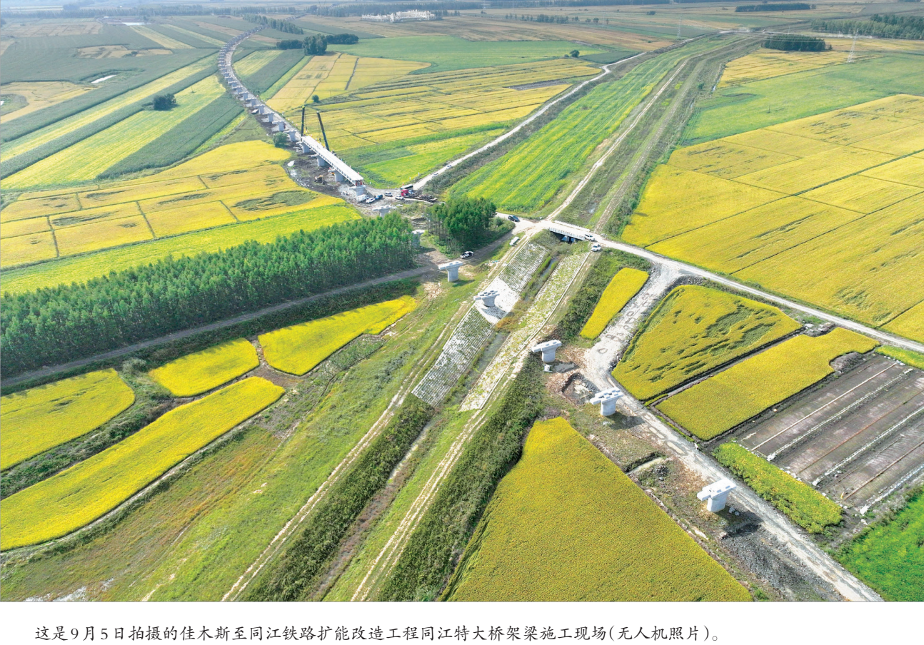
这是9月5日拍摄的佳木斯至同江铁路扩能改造工程同江特大桥架梁施工现场（无人机照片）。 9月5日，我国中欧班列“东通道”佳木斯至同江铁路扩能改造工程同江特大桥开始架梁施工。由中铁第五勘察设计院设计、中铁二十三局承建的同江特大桥是佳同铁路扩能改造工程全线控制性工程。桥梁全长10435.14米，采用单线T梁结构设计，预计将于2026年8月完成架设任务。 新华社记者王 松撰
