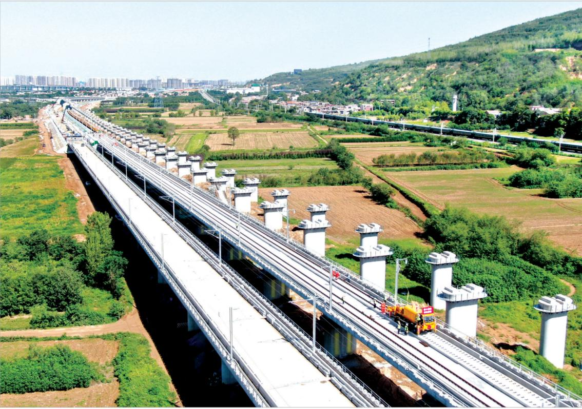
9月8日，施工车辆在西十高铁西安东至蓝田区间铺设无缝钢轨(无人机照片)。9月8日，在西十高铁建设现场西安东至蓝田作业区间，施工人员将首对500米长的无缝钢轨平稳铺设在无缝轨道板上，标志着由西成客专陕西公司建设、中铁四局施工的西十高铁全线铺轨正式启动。西十高铁西起陕西省西安市，向东南穿越秦岭山脉，终点为湖北省十堰市，正线全长255.76公里，设计时速350公里。
