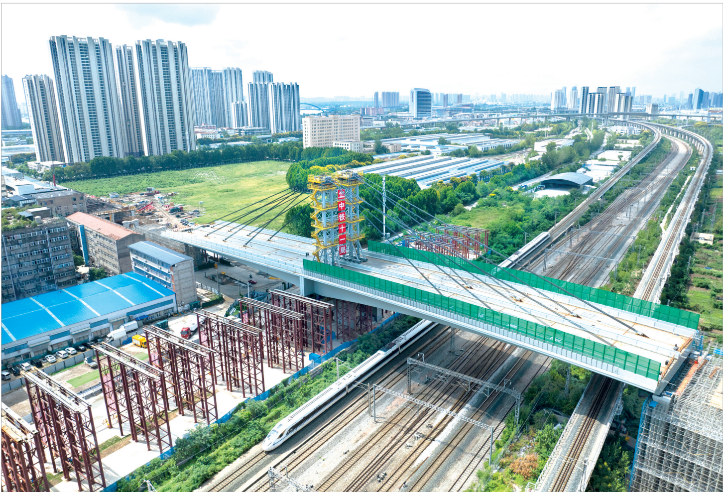
桥体成功转体后,列车从桥体下方驶过(9月11日摄,无人机照片)。9月11日,由湖北交投集团投资、中铁十一局集团承建的武汉市古田一路北段工程跨铁路立交桥成功转体,桥体平稳逆时针旋转81.7度,实现毫米级高精度对接。据了解,古田一路北段项目预计2025年底主桥建成通车,将有效疏通城市交通“堵点”,实现硚口区与东西湖区的快速联通。 新华社记者伍志尊摄
