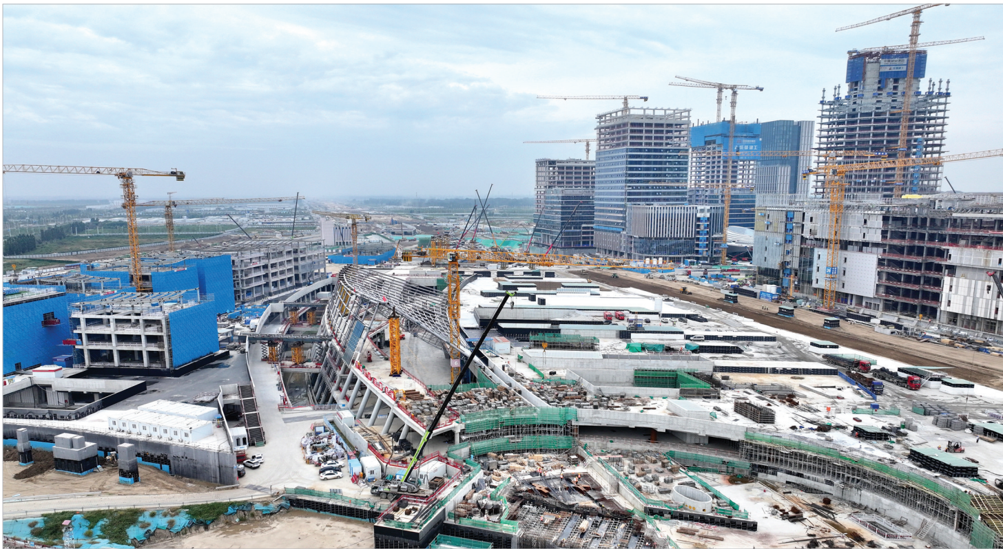
雄忻高铁雄安地下段及相关配套工程四标段建设现场(9月12日摄,无人机照片)。
