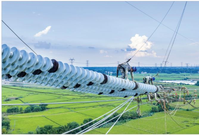
在安徽省芜湖市南陵县,安徽送变电工程有限公司施工人员在高空进行架线施工(9月16日摄,无人机照片)。近日,甘肃至浙江±800千伏特高压直流输电工程安徽段进入架线施工阶段。据悉,甘浙特高压工程是国家“十四五”电力发展规划重点项目,起于甘肃省武威市,止于浙江省绍兴市,全长约2370千米;投运后将有效促进西部“沙戈荒”大基地清洁能源外送,缓解华东地区电力供需矛盾,每年可向浙江输电电量超360亿千瓦时。
