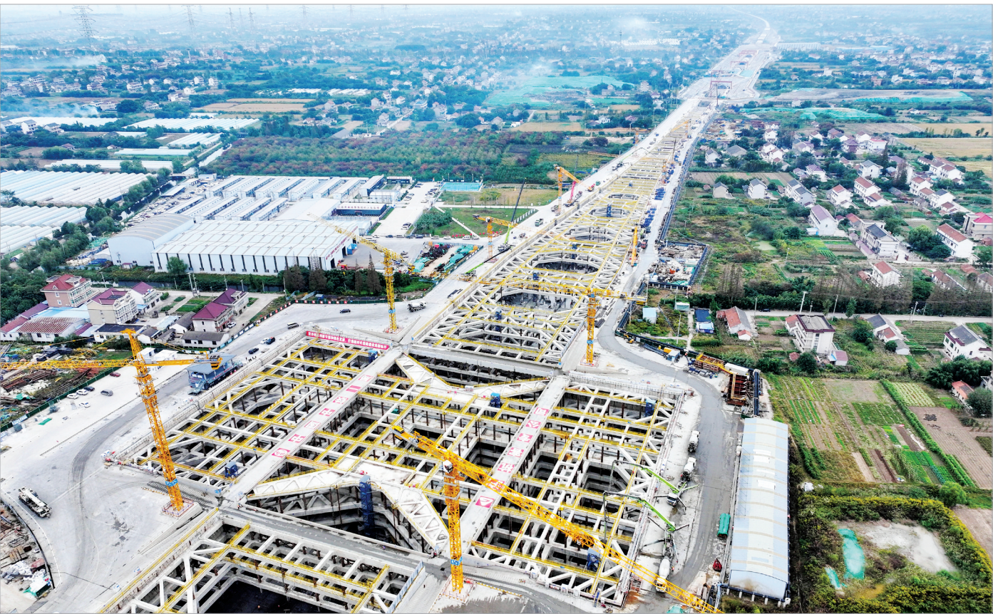
10月30日拍摄的海门北站建设现场（无人机照片）。10月30日，由中铁一局承建的新建沪宁合高铁关键控制性工程——海门北站核心区基坑最后一块底板顺利完成浇筑，标志着我国目前最长的超深超大基坑地下高铁站核心区基坑底板实现封底，项目建设取得阶段性进展。
