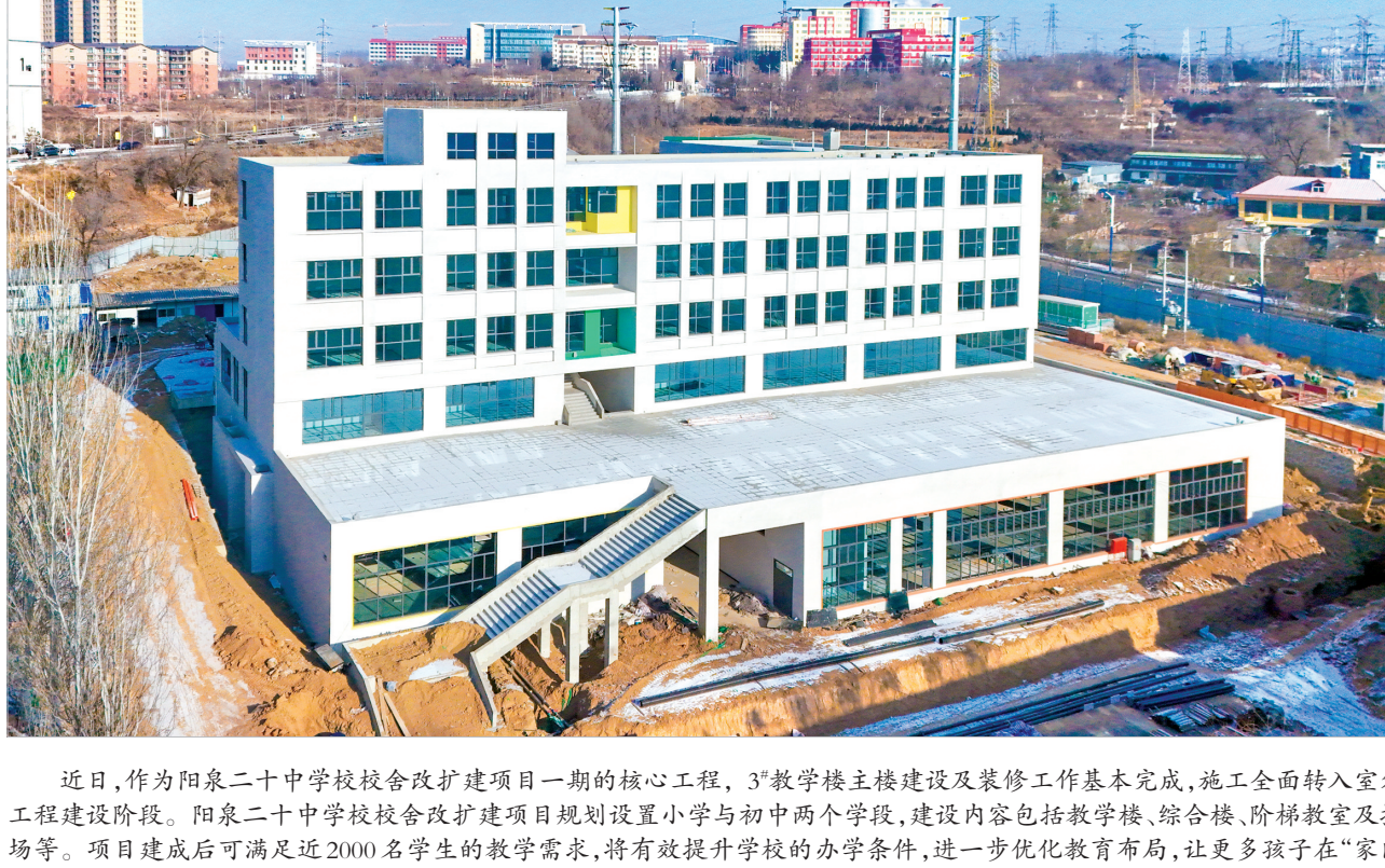
近日,作为阳泉二十中学校校舍改扩建项目一期的核心工程,3#教学楼主楼建设及装修工作基本完成,施工全面转入室外工程建设阶段。阳泉二十中学校校舍改扩建项目规划设置小学与初中两个学段,建设内容包括教学楼、综合楼、阶梯教室及操场等。项目建成后可满足近2000名学生的教学需求,将有效提升学校的办学条件,进一步优化教育布局,让更多孩子在“家门口”享受优质教育。图为1月20日无人机拍摄的现场项目现场。张泽慧
