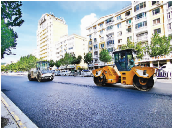
9月20日,南大街小阳泉路段施工现场,作业人员对路面进行硬化恢复。
