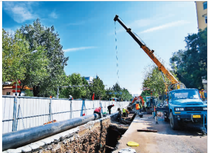
9月17日,在新泉北路,施工人员进行紧铺设热力管网。
