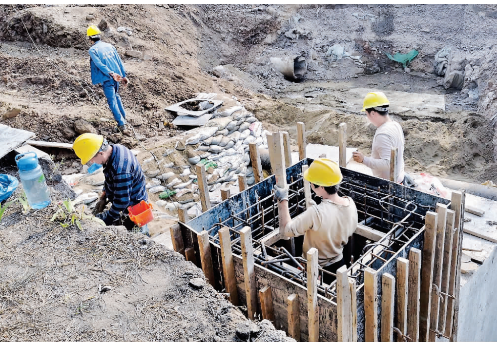
近日,阳泉市建成区雨污分流排水管网改造工程(二期)项目——义平路雨污分流改造工程正在加紧施工。该工程施工区域为富丽园至河下村村委会东侧路段及石板坪村至义井桥全段路面。路段进行半封闭施工,目前工程已进入收尾阶段。
