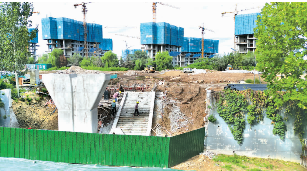
8月22日,阳泉市委党校(阳泉革命传统教育学院)异地搬迁改造附属配套一期工程——人行过街天桥钢结构工程项目正在加紧施工。该工程位于南大街(原工业学校路段),施工期间采取阶段性半封闭和全封闭的方式进行,预计本月底完工。 晋向华摄
