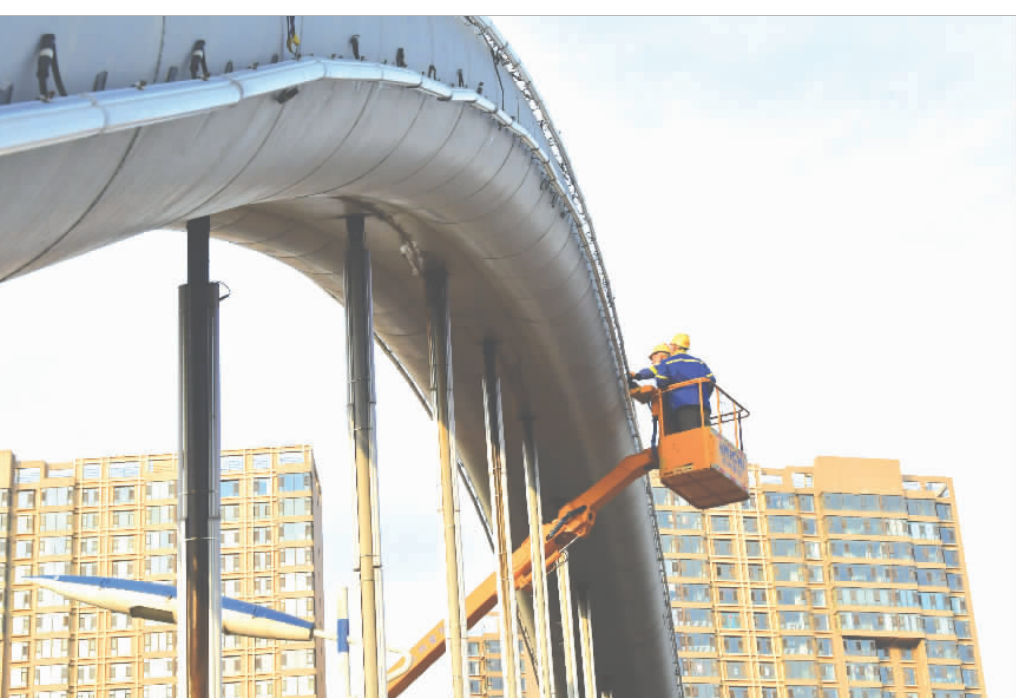
近日,市市政工程管理处的工作人员在新泉桥上排查照明设施是否存在安全隐患,并对存在问题的照明设施进行了修复、更换。 晋向华摄
