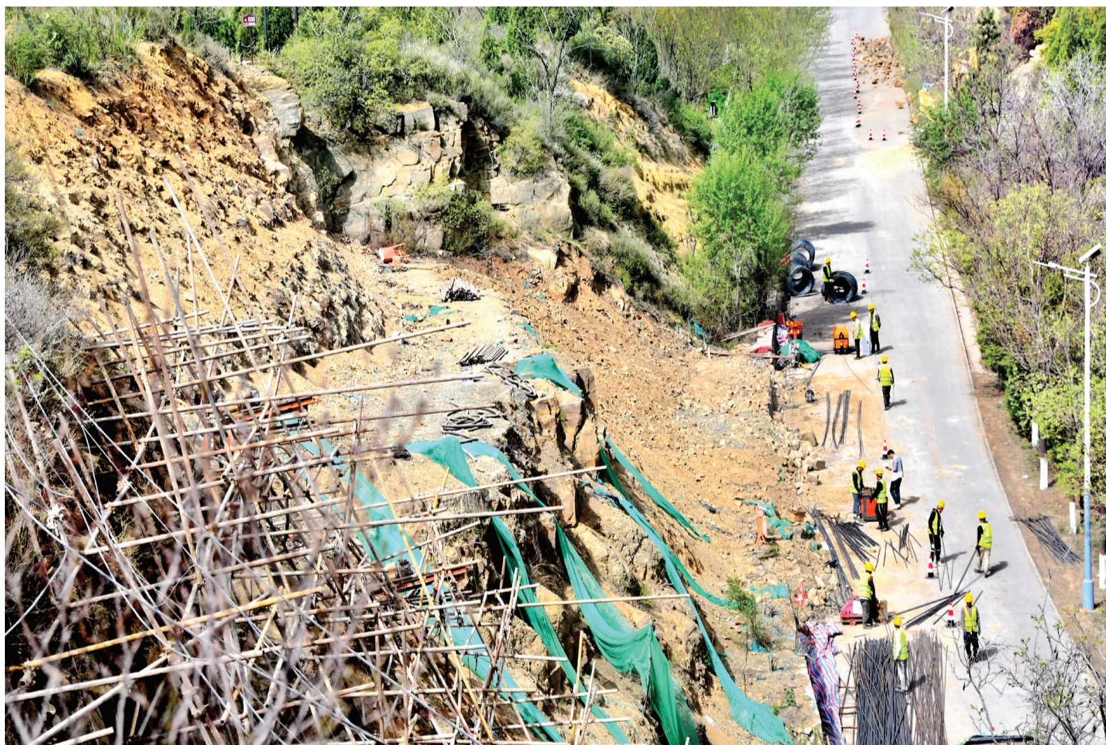
4月18日,狮脑山路地质灾害治理工程正在加紧施工。该工程施工起点在狮脑山路测速口,终点到百团大战纪念馆南门,预计7月中旬结束。施工期间进行临时交通管制。 晋向华摄
