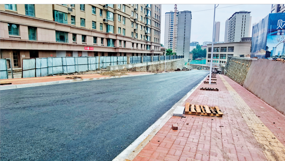
桃宸悦府南巷改造工程西起中源路,东至洪城北路,全长221米。图为近日该项目完成沥青混凝土路面铺筑。
