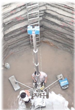
▲对古井进行三维扫描
