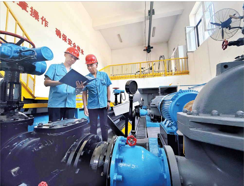
为应对夏季供水高峰,连日来,市自来水有限责任公司加大对设备的检修力度,重点对相关管线、仪表等进行维修保养,确保供水设施的安全运行,保证市民的正常用水。 贺海摄
