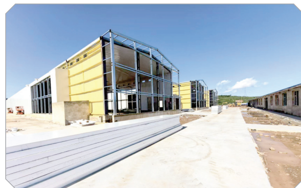
鸡舍主体建设基本完工
